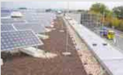
Flachdachabdichtung, Gründach, Photovoltaik, Blitzschutz und Klempnerarbeiten, alles auf einem Dach realisiert.
