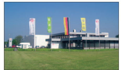
Know-how in Karosserieteilen: Das Firmengebäude in Bad Bentheim.
