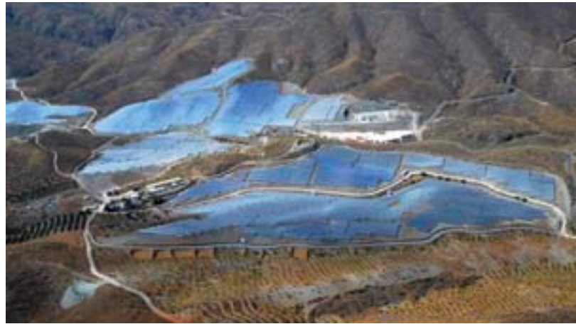
Drittgrößte Solarkraftanlage ihrer Art im spanischen Almeria mit einer Nennleistung von 23,7 MWp.
