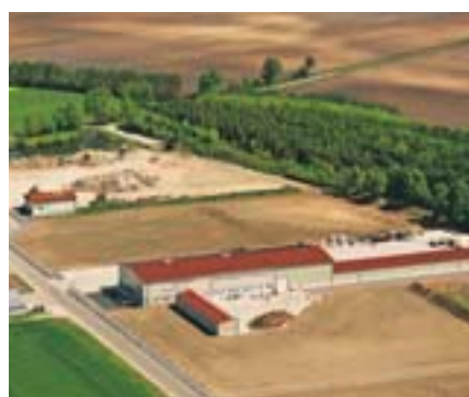
Im Jahre 2008 eröffnetes Betonfertigteilwerk in Lähden, spezialisiert auf Sonderbauteile.
