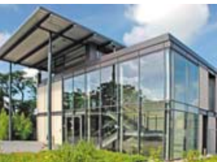
Beispiel einer gelungenen Altbausanierung mit Neubau: Die Stadtwerke in Lingen.
