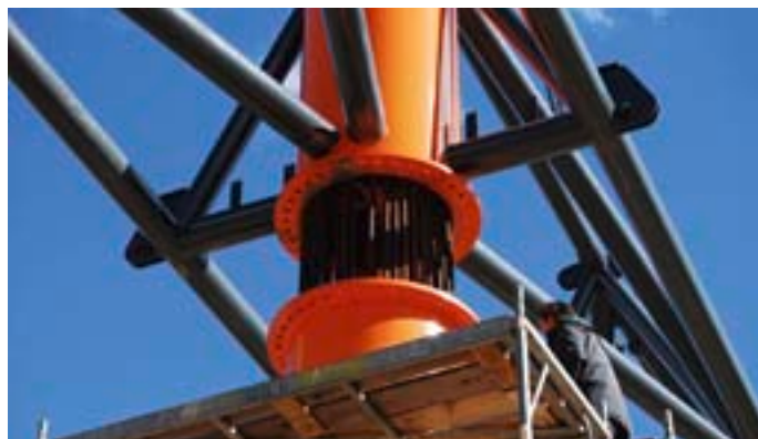
Auch komplexe Bauvorhaben, wie die Montage einer 65 m x 120 m großen Freiflächenüberdachung mit 3D-Rohrkonstruktion auf nur 6 Stützen, schrecken die Stahl-Spezialisten von Husen nicht ab.
