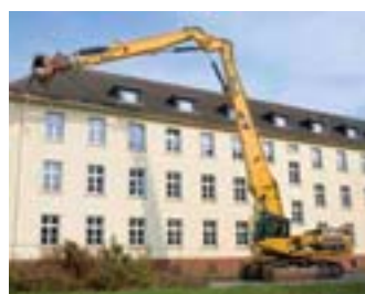
Gerade bei komplexen Abbrucharbeiten ist Augenmaß gefragt.
