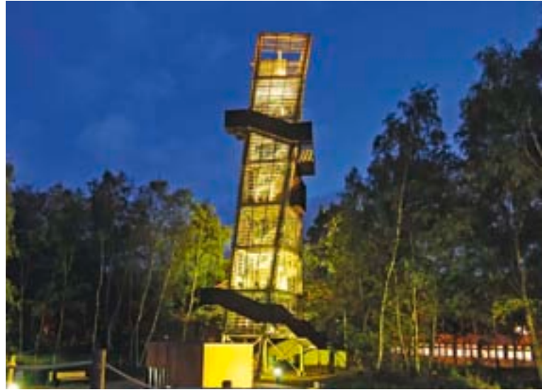
Vorzeigobjekt: Die Stahlkonstruktion des „Turm der Lüfte“ am Bremer Universum Science Center stammt von der Husen Stahlbau GmbH & Co. KG.
