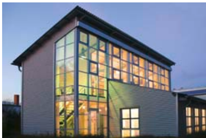
Glas und Metall architektonisch und optisch ansprechend kombiniert: Das Bürogebäude der Kreativmetall Metallbau GmbH & Co. KG.
