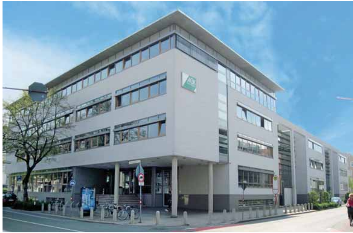
Das AOK Servicecenter in der Niedersachsenstraße 10 in Osnabrück.
