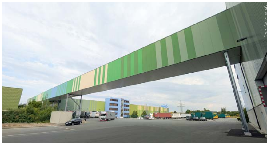
Der 2025 umgesetzte Bau dieser Verbindungsbrücke zwischen zwei Werkshallen der Sandler AG in Schwarzenbach ist Teil der Automatisierungsinitiative.
