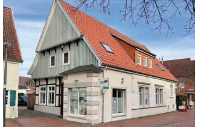
Am Kirchplatz: Hier sind die Räume für den Pop-Up-Store.
