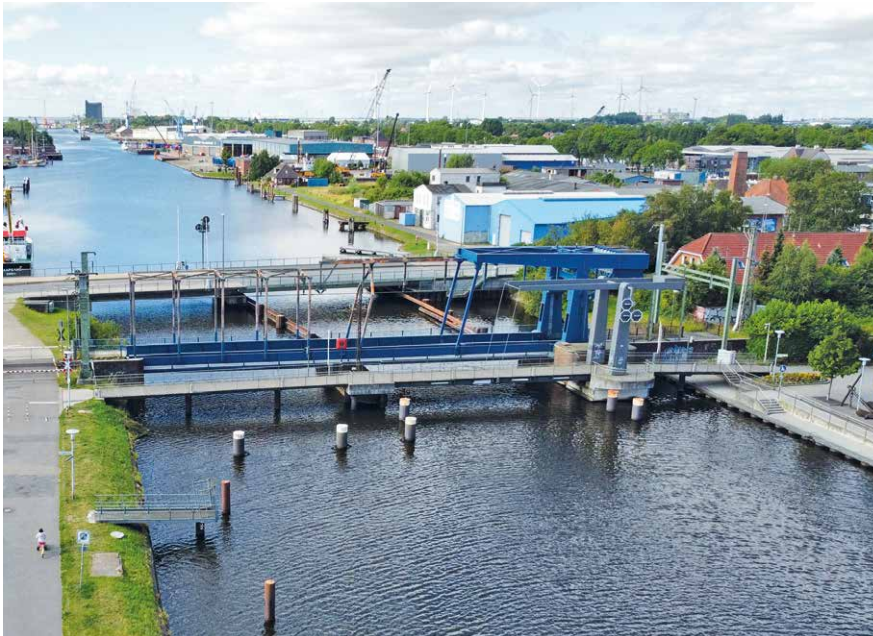
Eine zweite Eisenbahnklappbrücke ist unerlässlich für eine permanente Erreichbarkeit per Bahn sowohl beim Güter- als auch beim Personenverkehr in Emden. Bild: IHK für Ostfriesland und Papenburg
